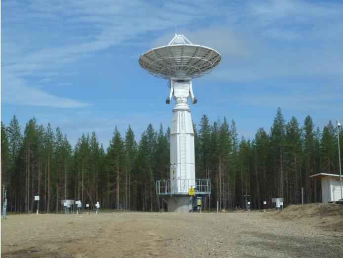
写真2 フィンランド気象庁（FMI）のarctic research centerが所有する衛星通信レーダー。定期的にアンテナを人工衛星の方に向け、情報を取得する。
